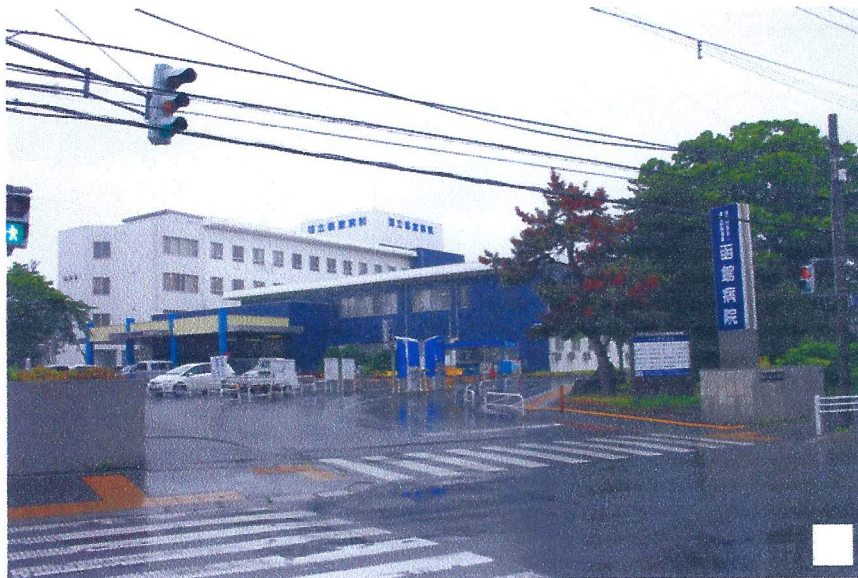
八雲病院の患者の一部を受け入れる国立病院機構函館病院。正面出入り口の裏側に建物を新築した=2020年6月25日、北海道函館市川原町
